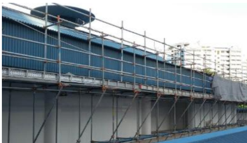
圖 31 懸挑式腳手架
